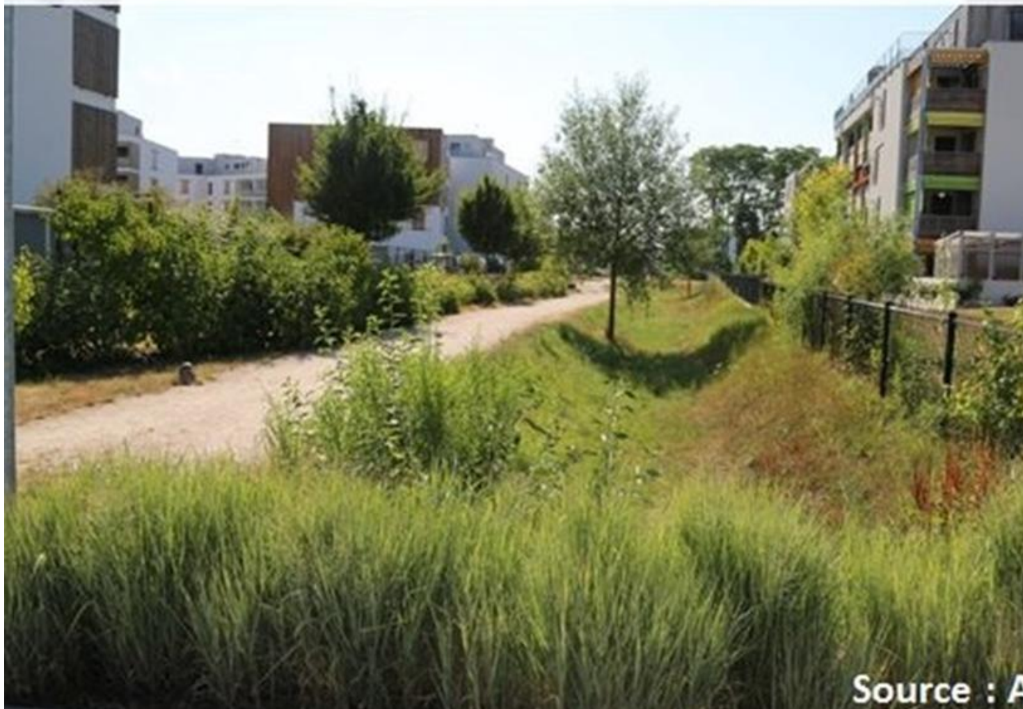
Noue d'infiltration, Strasbourg (67)
